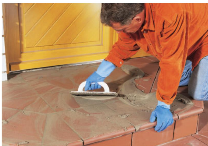
5. FBR 300 – заполнение швов
