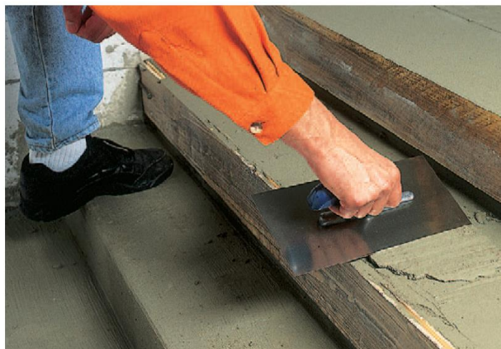
2. BRS – ремонт основания
