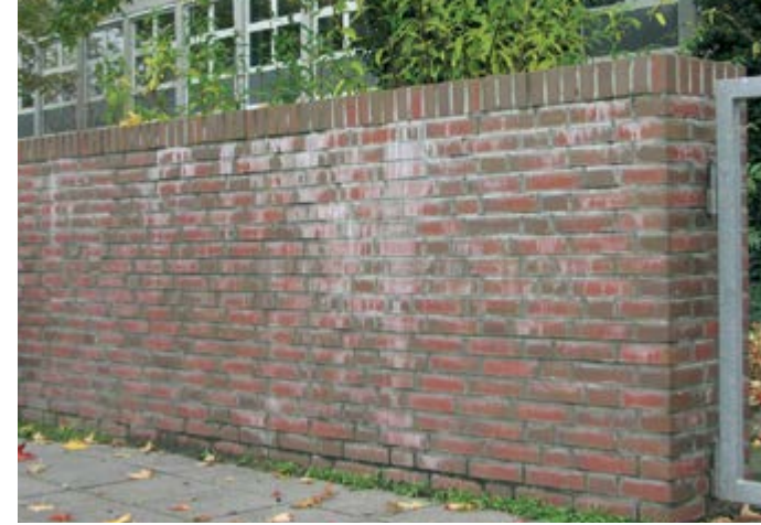
So bitte nicht: Die Oberkante dieser Mauer wurde manuell erstellt. Die Folge: Regenwasser dringt ins Mauerwerk ein und verursacht hässliche Auslaugungen. Mit einer vorgefertigten Mauerwerks-Abdeckung von Rößen wäre das nicht passiert.
