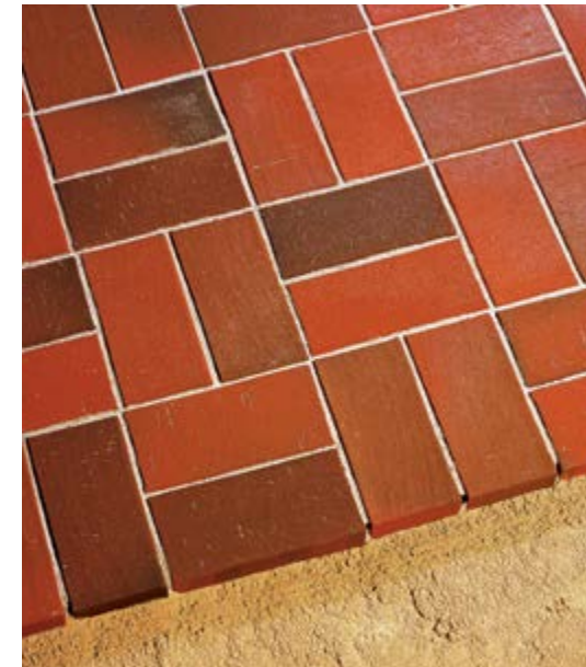
Abwechselnd je zwei Pflasterklinker in gegenläufiger Richtung verlegt.
