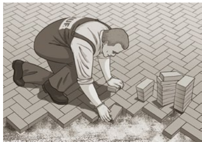
Мощение поверхности с формированием узора «елочка».
