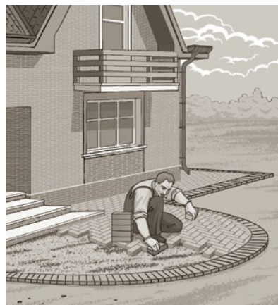
Укладка очередных рядов клинкерной брусчатки.
