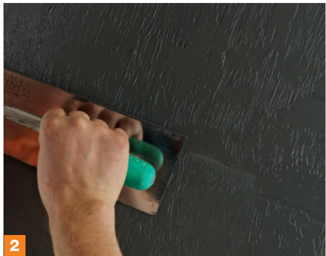
2 In die noch frische Masse wird die Schieferstruktur eingearbeitet. Dazu etwas Spachtelmasse vollflächig auf die Glättkelle geben und strukturieren.
