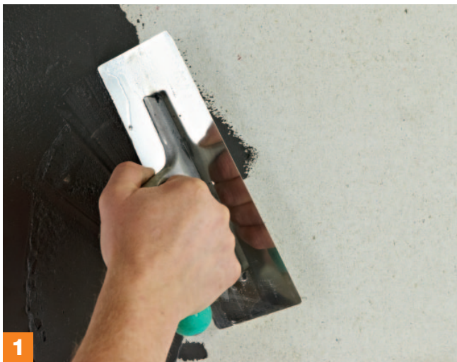
1 Mit Eisenoxidpigment oder Abtönfarbe* „schwarz“ eingefärbten Q4 Glättspachtel auftragen.
