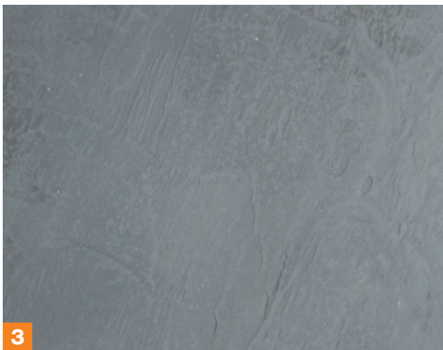
3 Fertig strukturierte Fläche durchtrocknen lassen.
