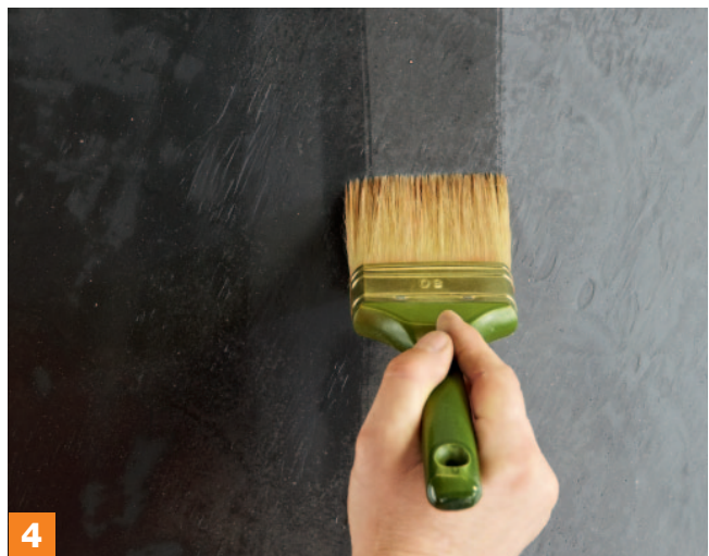
4 Um gewünschten Farbton und -glanz zu erhalten, mit einem sauberen Pinsel quick-mix ATG Acrylat Tiefengrund dünn auftragen. Ggf. wiederholen.
