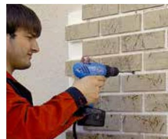
Рис. 24.2. Крепление термопанелей
