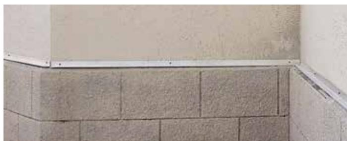
Рис. 21. Вид смонтированного стартового профиля
