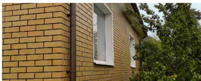
Рис. 27. Вид смонтированного водостока на фасад, облицованный термопанелями
