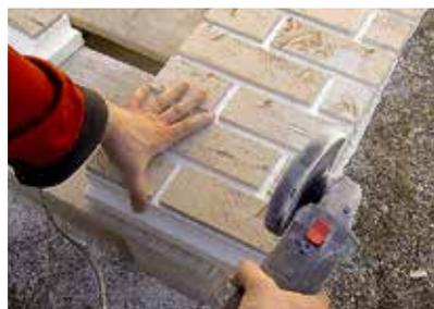
Рис. 25.1. Подрезка термопанели алмазным диском
