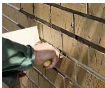
Рис. 29.1. Заполнение швов затиркой между плитками
