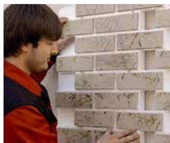
Рис. 24.1. Крепление доборного элемента термопанели
