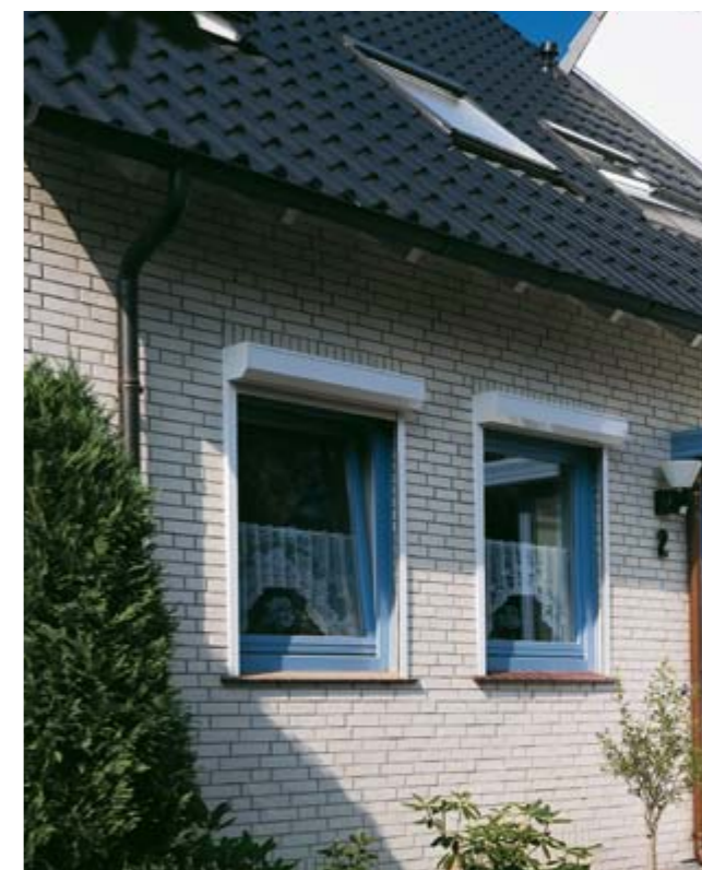
Прекрасный пример ремонта фасада со штукатурной облицовкой – до и после. Плитка MALMÖ, серебристо-белого цвета, формат NF.
